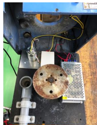
写真8 組み込み完了
