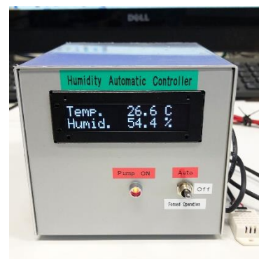
写真7 完成と動作確認
