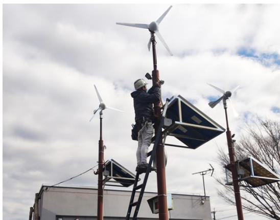
写真1 取り外し工事
