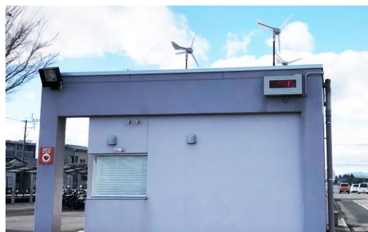
写真6 修理・取り付け復旧終了
