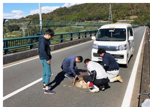
写真5 路上にあるマンホールの蓋
