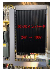
写真7 故障と診断されたインバータ
