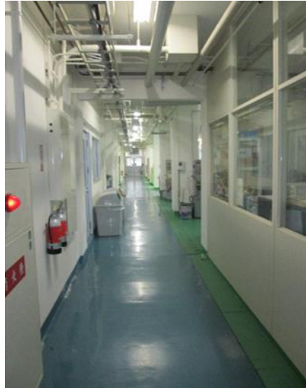
扉が撤去されました
