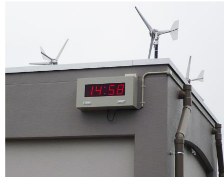
写真8 守衛室壁面へ設置完了
