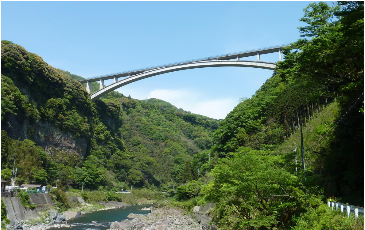
写真1 天翔大橋全景（橋中央部右寄りに風力発電設備）
