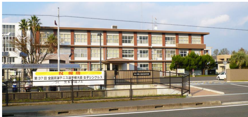
写真2 ＜新正門＞ 左手に守衛室と 自然エネルギー システム
