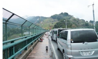
写真9 配線工事風景
