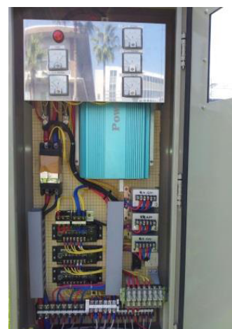
写真 9 新規制御盤
