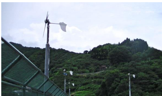
写真2 風力発電機設置外観
