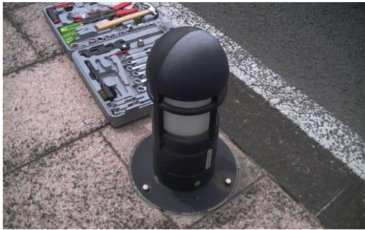
写真8 照明器具外観
