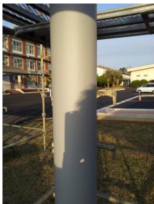
写真10 防食塗装（支柱）
