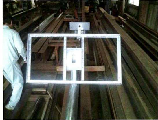
図 12 ソーラーパネル取付け
