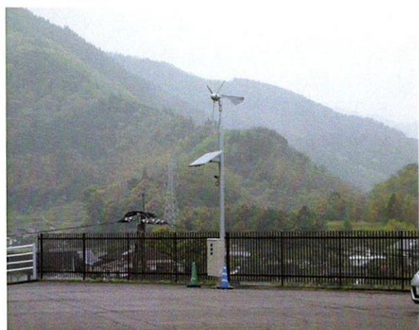
図 14 独立型ハイブリッド発電システム
