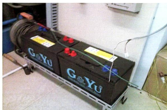
図7 密閉型ディープサイクル型バッテリー仕様
