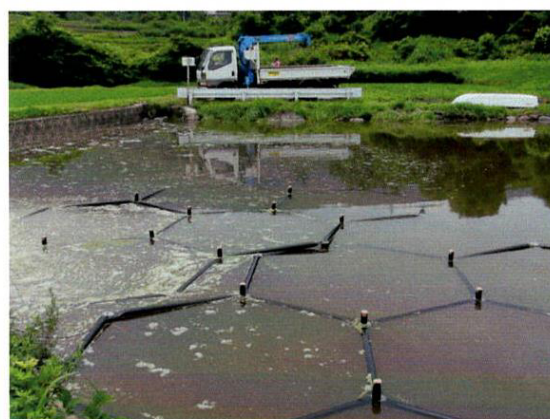
ユニック車による池への投入作業
