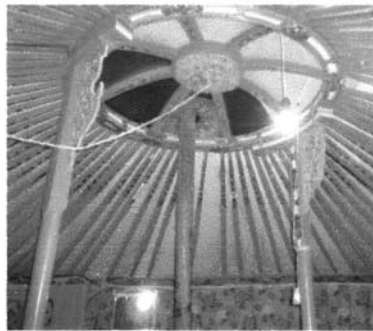
(2)中央の柱と煙突の通る円形部分
