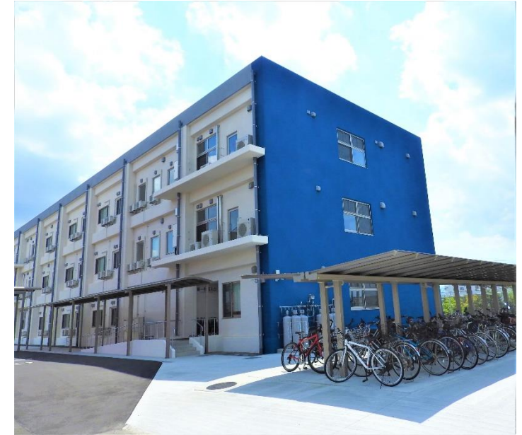
第1棟(令和4年度竣工)
