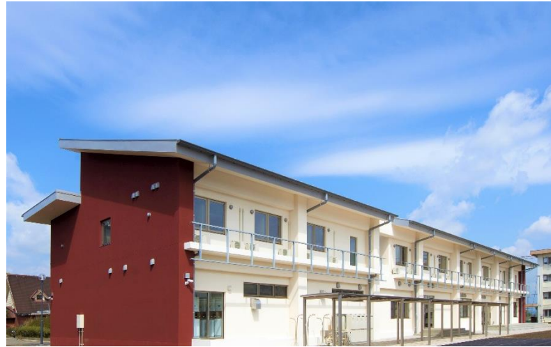
管理棟(令和3年度竣工)
