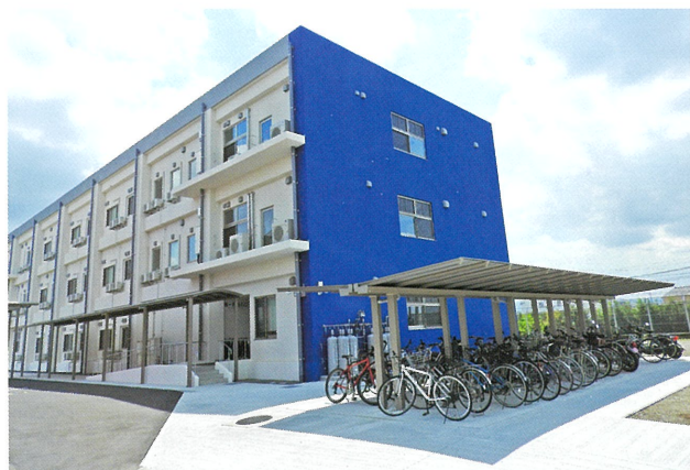
第1棟(令和5年度竣工)
