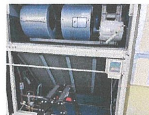
洗浄後の内部（下部）
